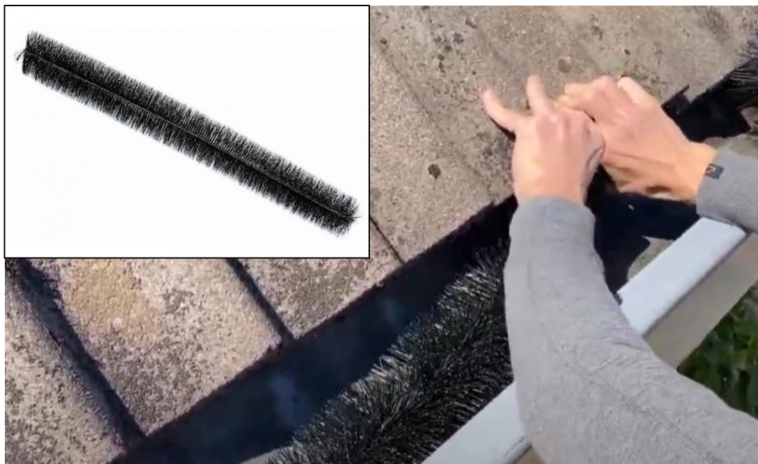
Foto 1. Borstels die gedrukt worden onder de dakpannen.
