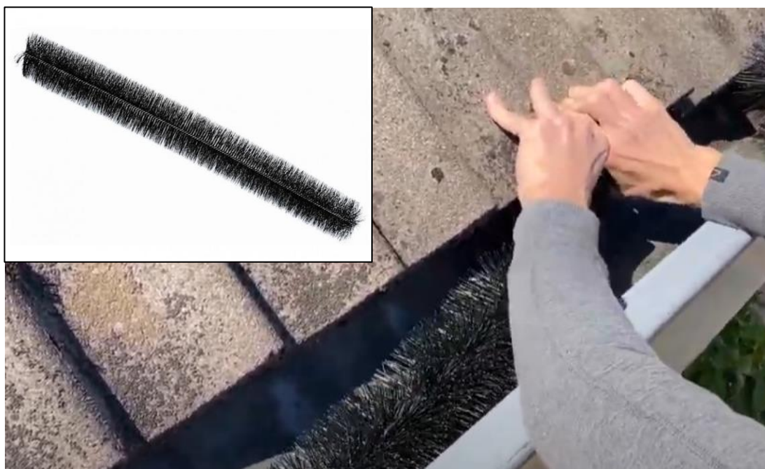
Foto 1. Borstels die gedrukt worden onder de dakpannen.
