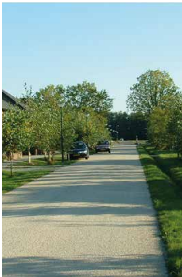
Asfalt (zie onder) met slijtlaag en streklagen van klinkers
