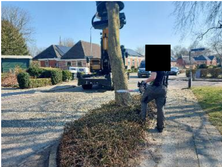
Afb.11: Aannemer aan het werk op de openbare weg, de Boermanjeweg in Usquert. De wettelijk verplichte signaalkleding welke moet voldoen aan de NEN-EN 471 ontbreekt. Daarnaast ontbreken ook veiligheidsvoorzieningen zoals bebordingen en hekwerken evenals een goede afzetting van de rijbaan en het trottoir.
