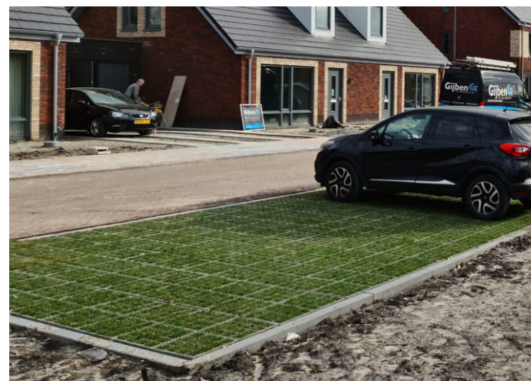
Afbeelding 36: referentiebeeld voor de bestrating van de langspaarkeerstroken in de woonstraten, uitgevoerd in grasbetonkeien.
