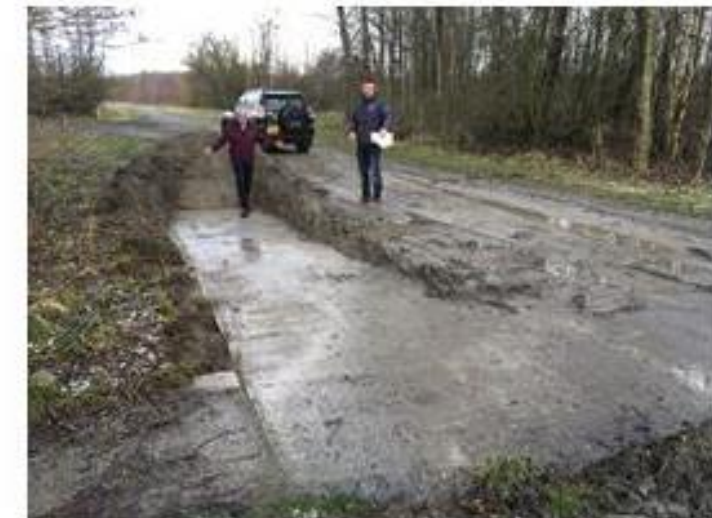
Vrijgegraven duikende betonplaat ter plaatse van Oversteekpunt fietsers
