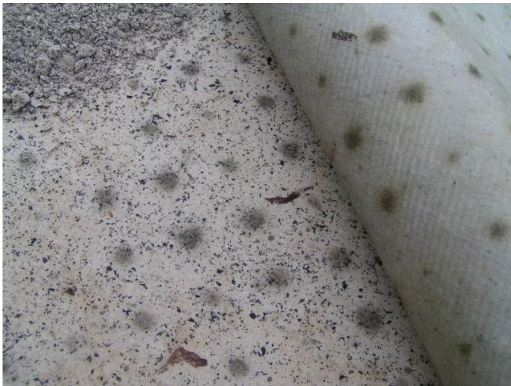
Foto 15: vervuilde perforaties in geovlies en sporttechnische laag zo-hoek veld
