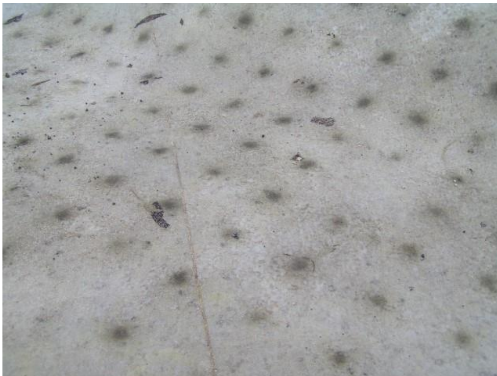
Foto 16: vervuilde perforaties in geovlies en sporttechnische laag no-hoek veld
