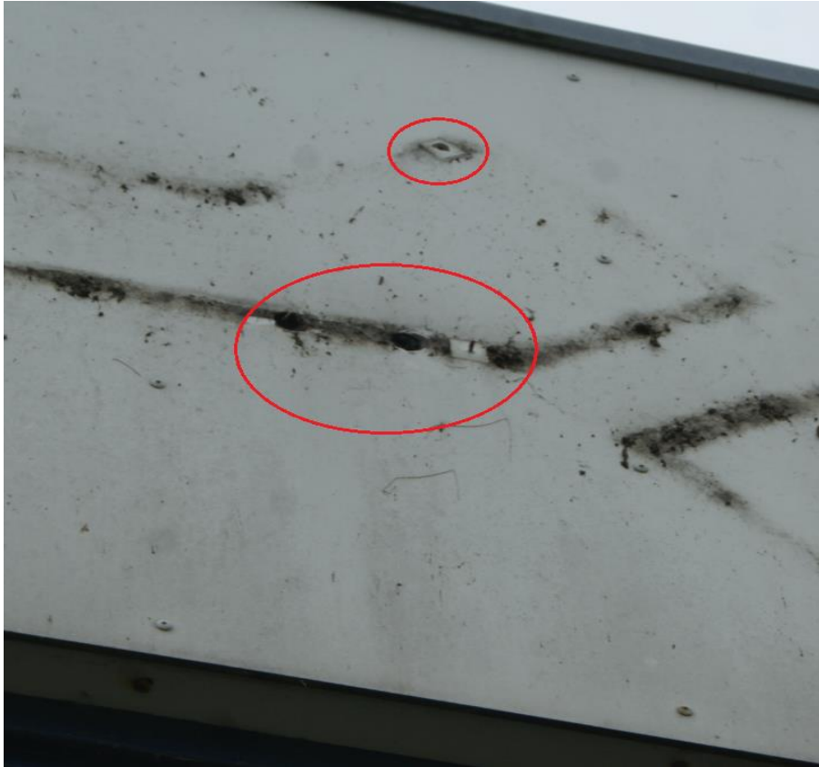
Fig.5.4a Gaten in Trespa-platen waar het logo bevestigd was (Bron: Eco Reest).
