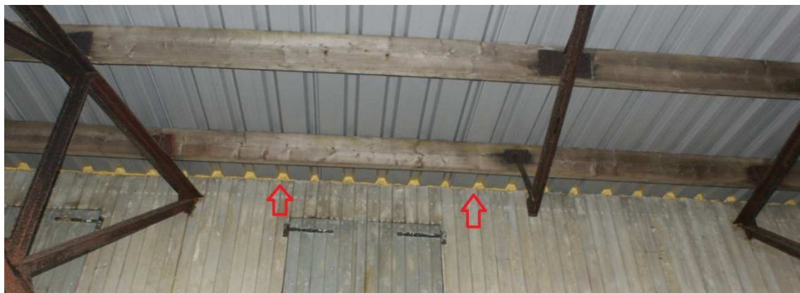
Figuur 5.3. Aansluiting dakplaten machinefabriek op gevel (geïsoleerd met pur tegen condens- en schimmelvorming)
