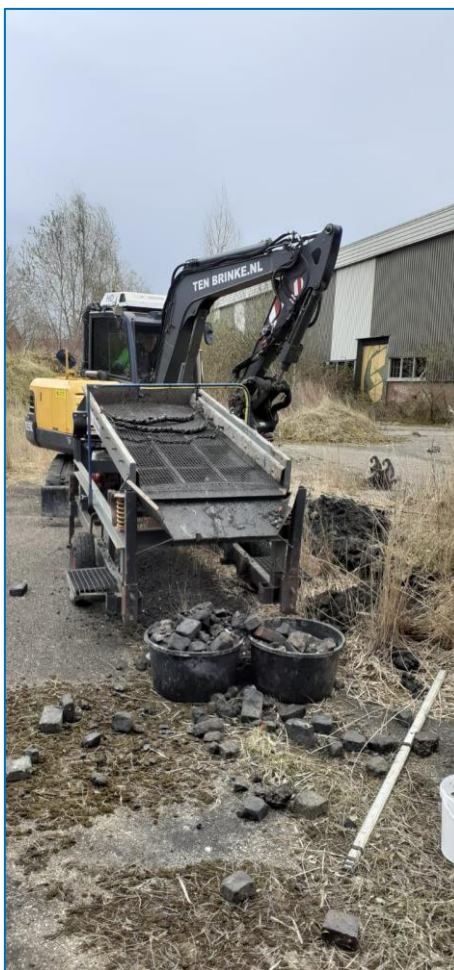
foto 3. Zeefwerkzaamheden westelijk deel met rood baksteenpuin (links) en oostelijk deel (ook ander puin)
