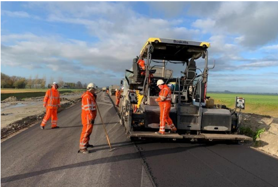
Figuur 1: aanbrengen asfalt met een spreider
