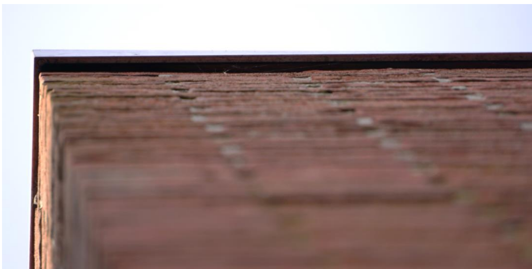
Figuur 4.3 De dakrand van het noordwestelijke gebouw is strak aangesloten op de gevels.
