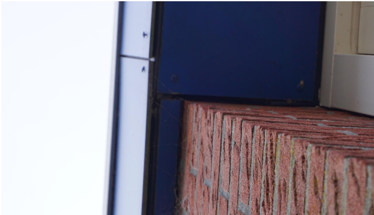
Figuur 4.2 De dakrand van het zuidoostelijke gebouw is strak aangesloten op de gevels.
