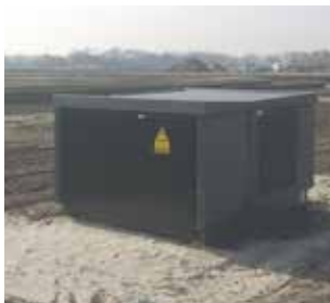
Links: openbare verlichtingskast. Rechts: trafokast.
