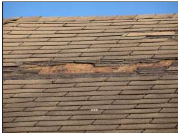
Figuur 11. Onder het bitumen ligt houtwerk, waardoor er geen ruimte is onder de dakbedekking.
