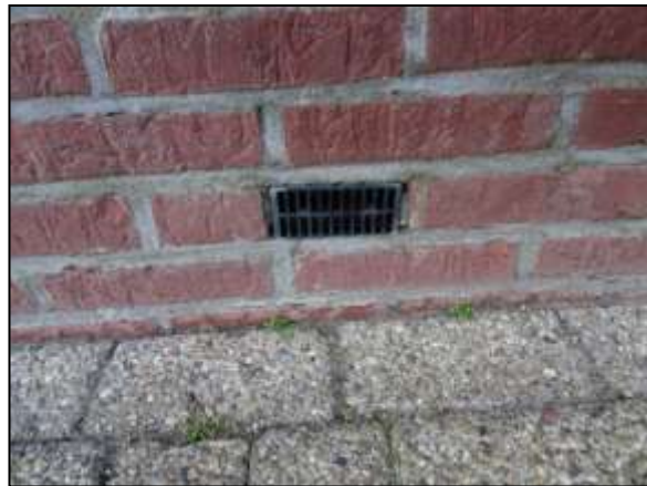
Figuur 16. Voorbeeld van een muuropening voorzien van een intact rooster.
