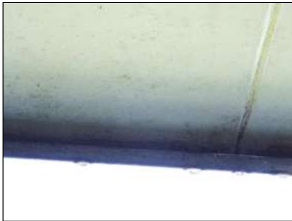
Figuur 15. Strak afgewerkte dakranden.
