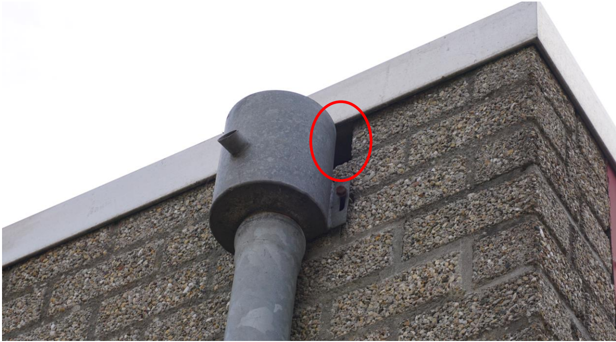
Figuur 4.7 Achter de regenpijpen van het hoofdgebouw ontbreken bakstenen, waardoor openingen voor vleermuizen aanwezig zijn om de spouw en/of het dakvlak te bereiken.
