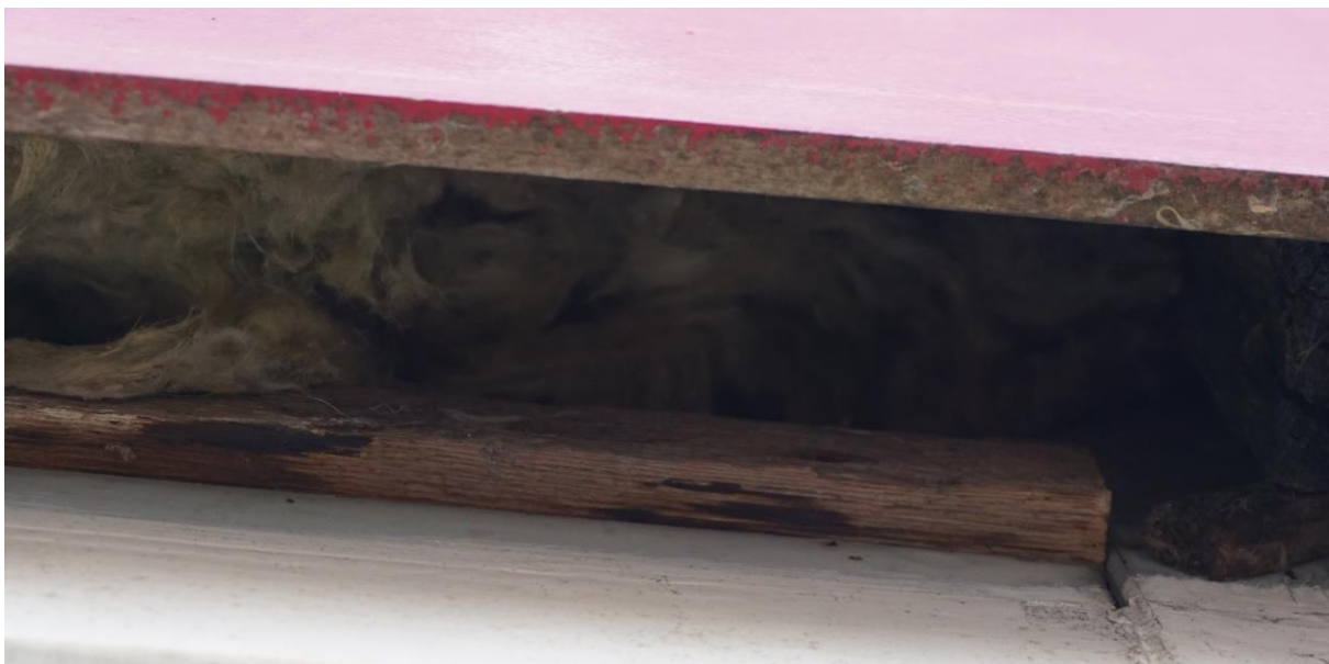
Figuur 4.3 De boeiboorden zijn gevuld met steenwol.
