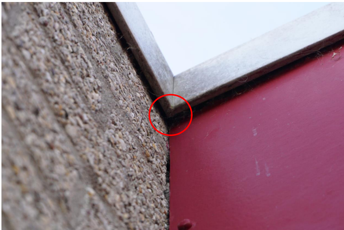
Figuur 4.5 Op enkele plekken langs de dakrand is voldoende ruimte aanwezig voor vleermuizen om het dak te bereiken.
