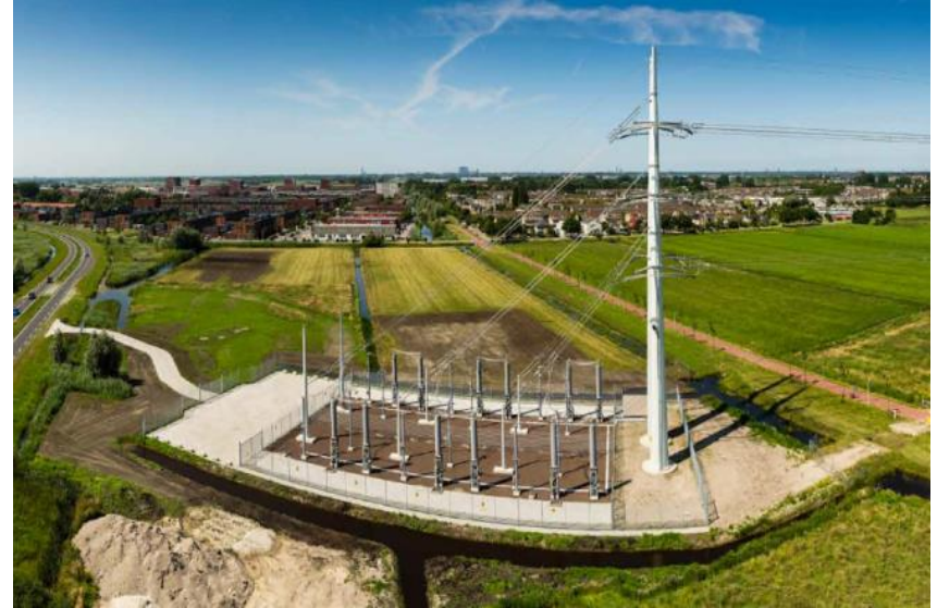
Impressie van een opstijgpunt (voor een 4 circuit verbinding ongeveer 2 maal zo groot)
