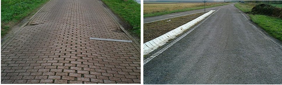
Figuur 2 Schades dwarsonvlakheid en rafeling
